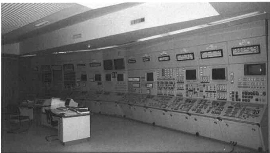
Centrala nuclearelectrică de la Cernavodă — panoul de comandă al primului reactor al centralei (7 mart. 1996)
