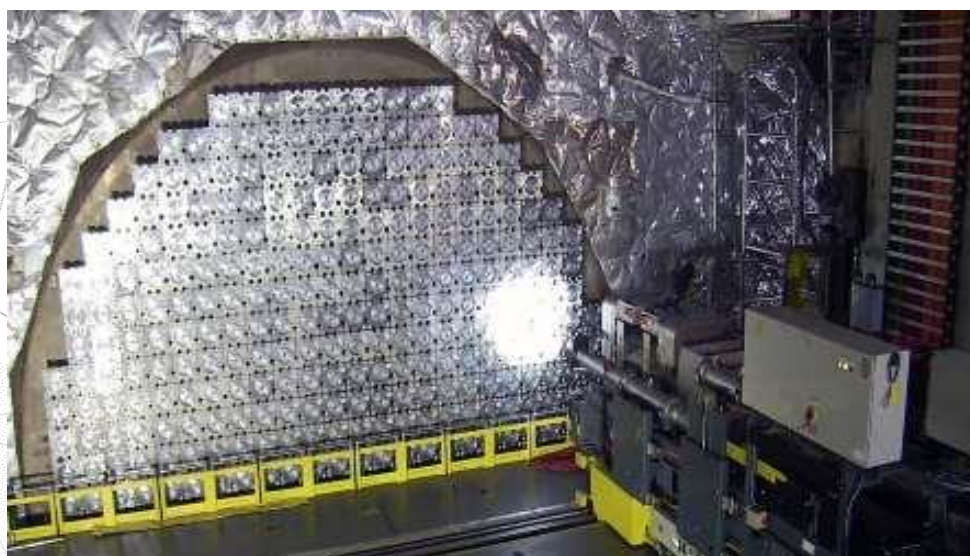
Imagine din interiorul reactorului de la Unitatea 2 Darlington, Canada, în timpul retehnologizării.
