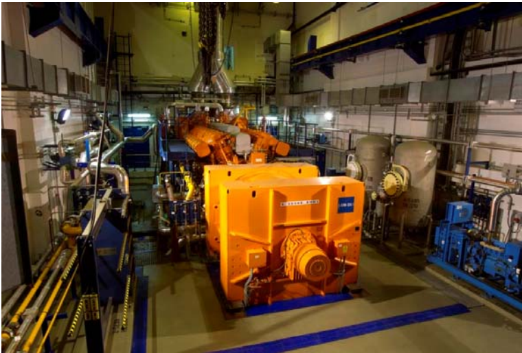
Un grup electrogen de rezerva de la una dintre unitati
